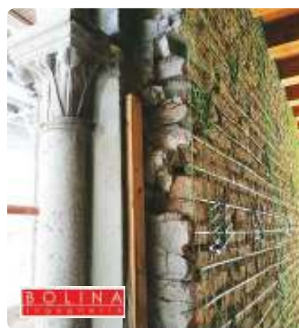
Rinforzo di muratura storica con fibra di vetro e trefoli in acciaio inox in corso di esecuzione
