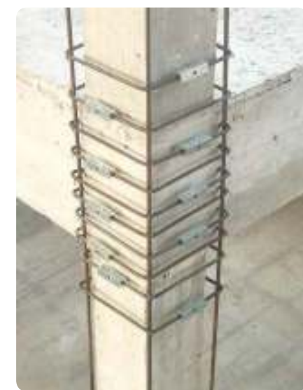
Giunzione meccanica GTS per barre d'armatura
